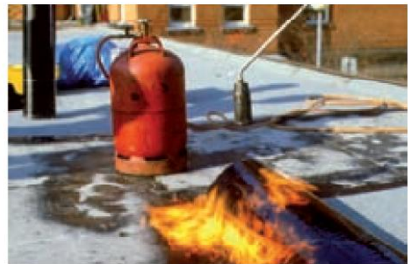
Abb. 1: Typische Zündquellen auf der Baustelle, Quelle: VdS 2216
